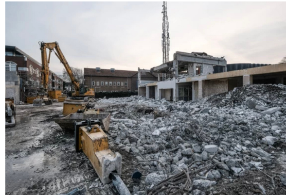
Na het vertrek van C-1000, in 2012, heeft het pand ruim 6 jaar leeggestaan. In 2019 is het gesloopt. Nu staat op die plek Parkgebouw De Veentjes.
